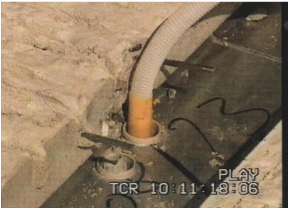
*Paßgenaues, geschoßübergreifendes Versorgungs-Rohr für Strom*
