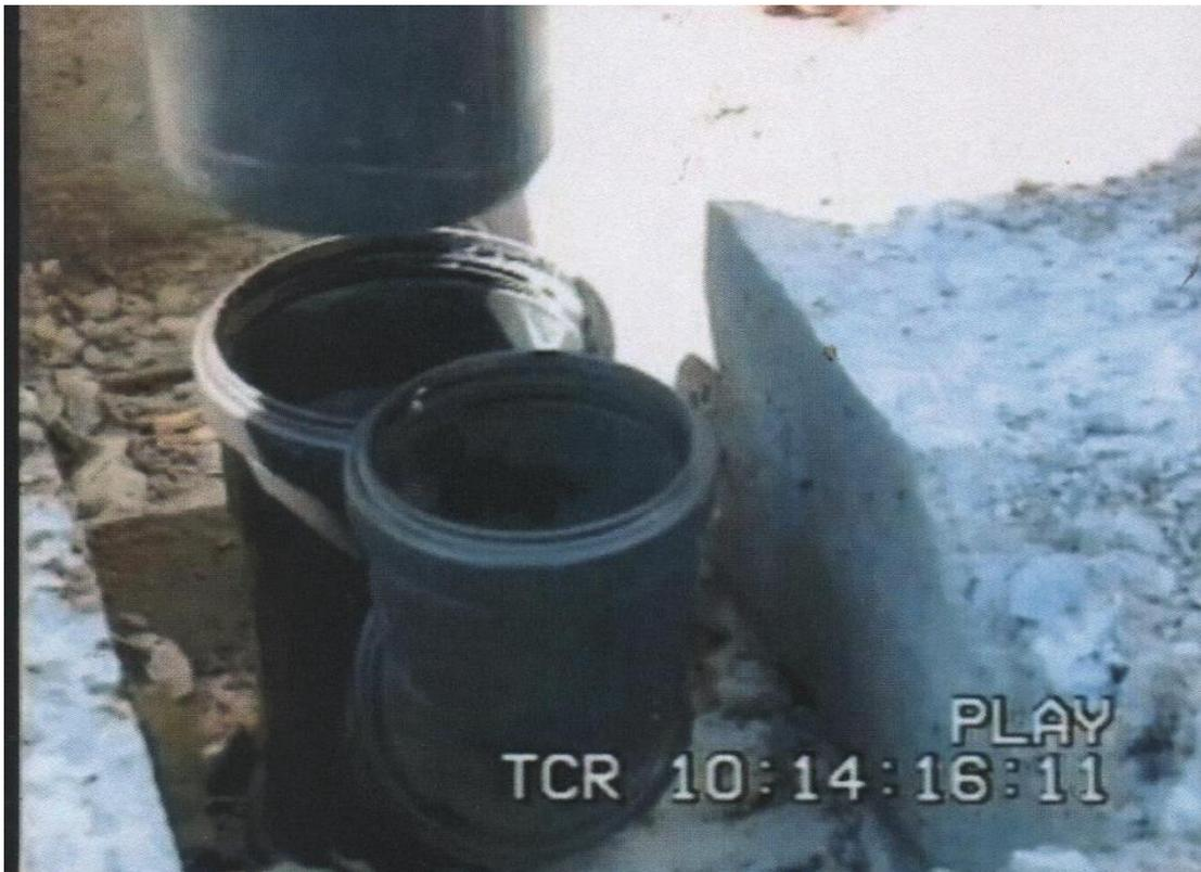
*Geschoßübergreifende Muffen für die Wasser-Rohre*
