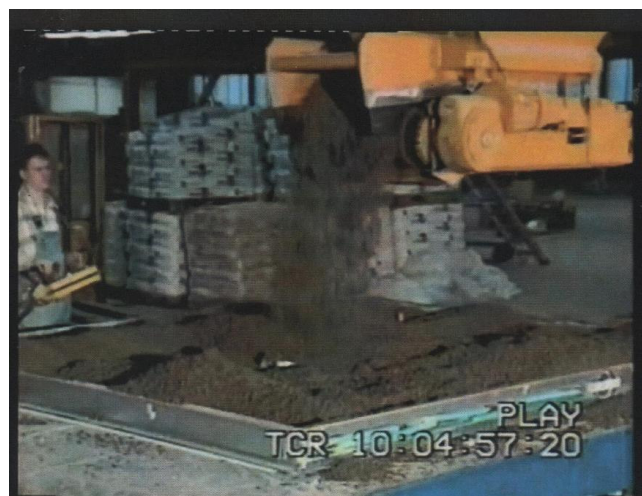
Die 'Schublade' wird mit Blähton ausgegossen (Quelle: DMPG-Film)
