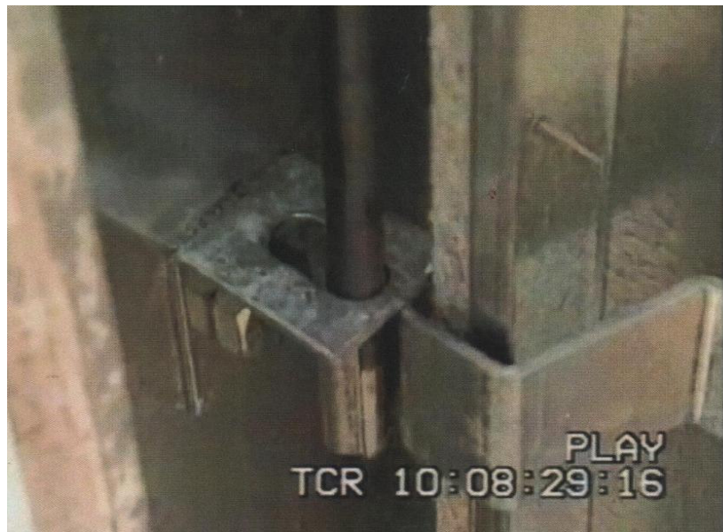
Millimetergenaue Verbindungs-Teile für die geschoßübergreifenden Wände (Quelle: DMPG-Film)
