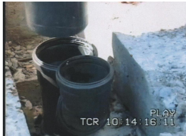
Geschoßübergreifende Muffen für die Wasser-Rohre (Quelle: DMPG-Film)
