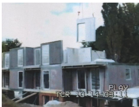
Geschoßübergreifende Montage, hier für ein 10-Familien-Haus (Quelle: Film über die DMPG)
