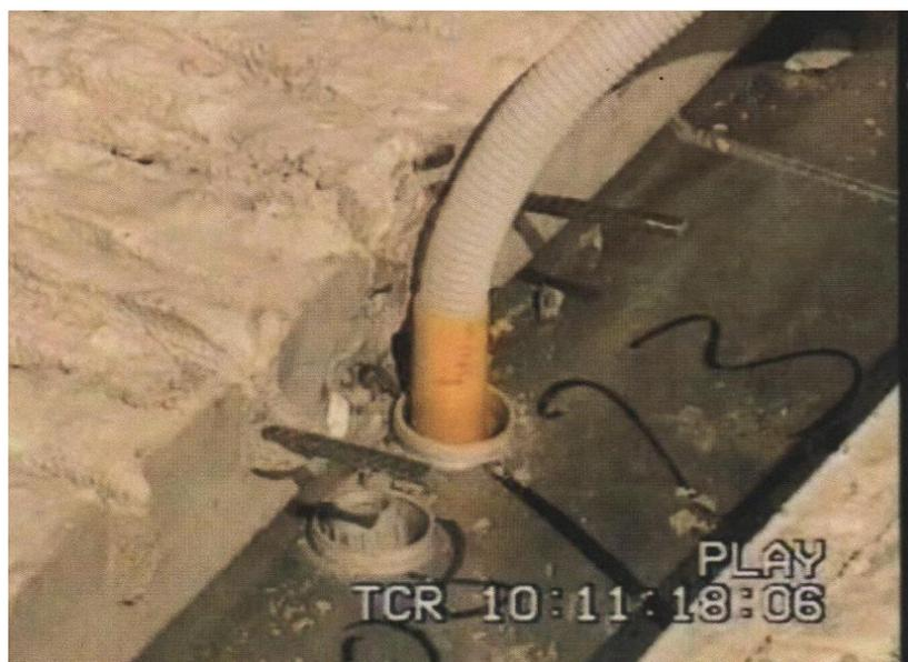
Paßgenaues, geschoßübergreifendes Versorgungs-Rohr für Strom (Quelle: DMPG-Film)
