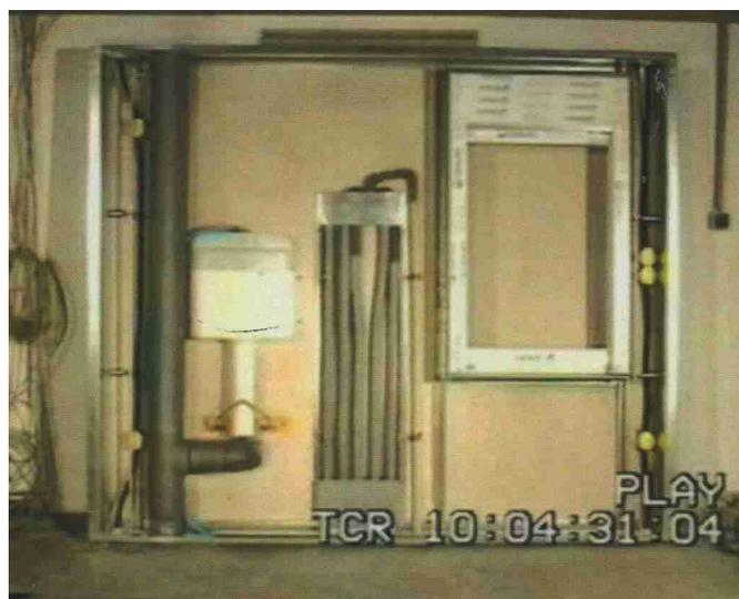
Vorinstallierte Wasser-, Heizungs- und Elektro-Leitungen sowie Fenster, schon mit Glas (Quelle: Film über die DMPG)
