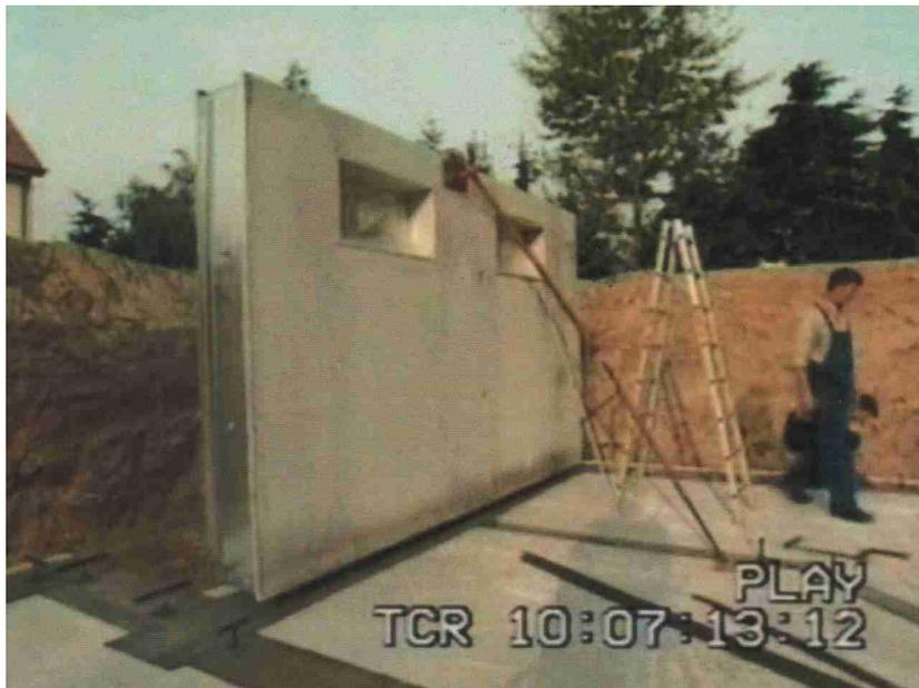
Alles paßt millimetergenau auf- und zueinander. Hier sieht man die Fermazell-Platte, die als *malerfertige* Innen-Wand fungiert (Quelle: Film über die DMPG)
